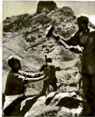
Строительство Большого Памирского тракта. 1940 г.
